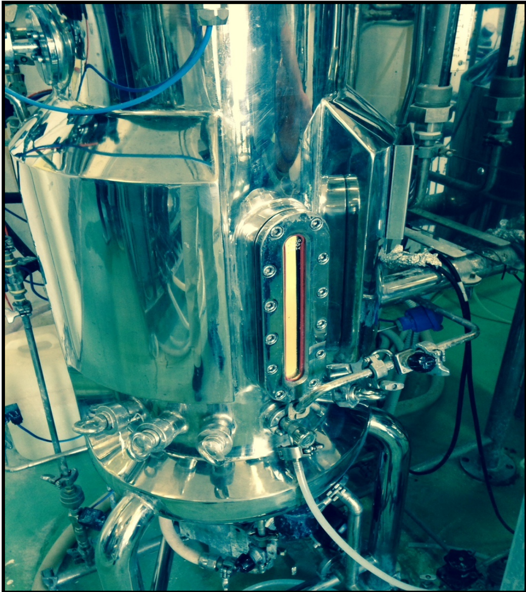
fermentatore vegetativo, 80L dell'impianto di Minerbio
